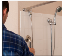
Instalamos barras de sostén para su seguridad.
