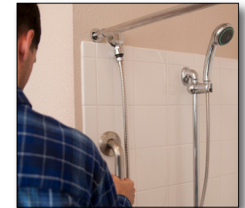
Instalamos barras de sostén para su seguridad.
